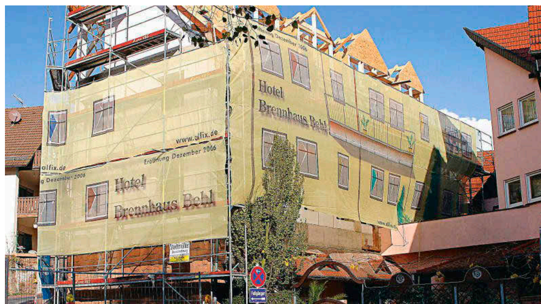
Richtfest 2006: Der Dachstuhl für das neue Hotel ist fertig, kein Balken gleicht dem anderen, keine Ecke des Hauses ist rechtwinklig.
